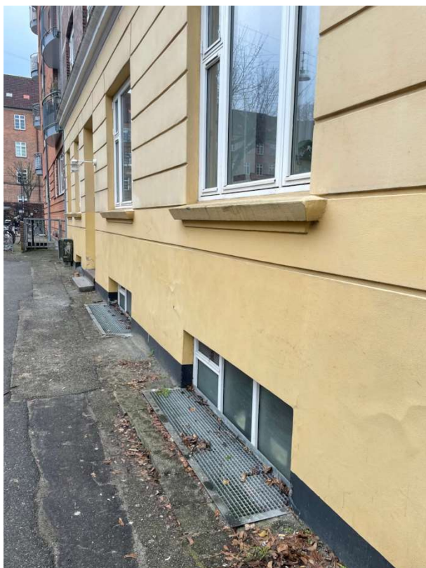
Belægning mod gade som asfalt ind mod facade
