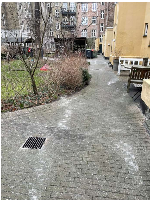
Belægning mod gård - betonfliser i ganglinje
