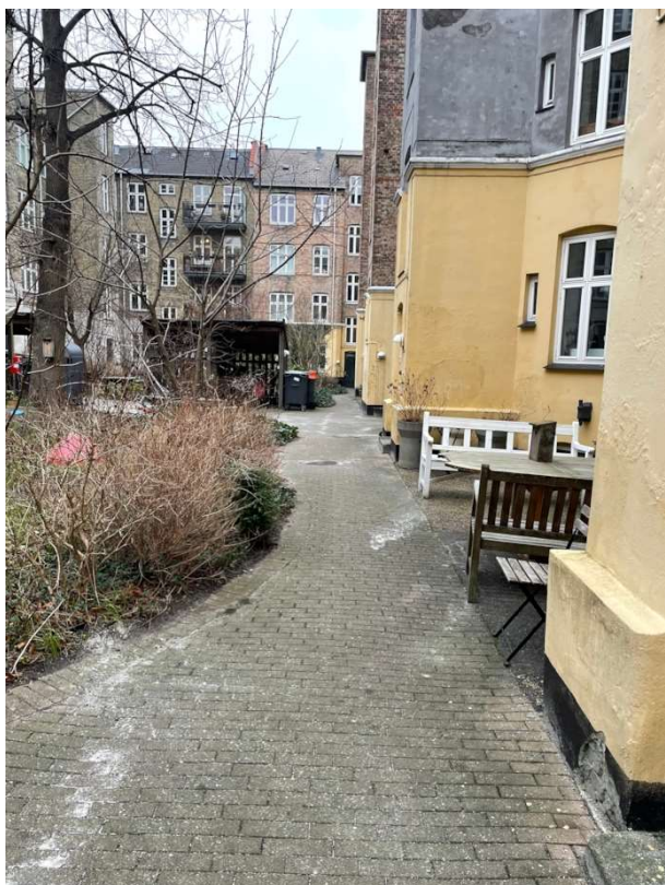
Belægning mod gård er udført som betonfliser og asfalt
