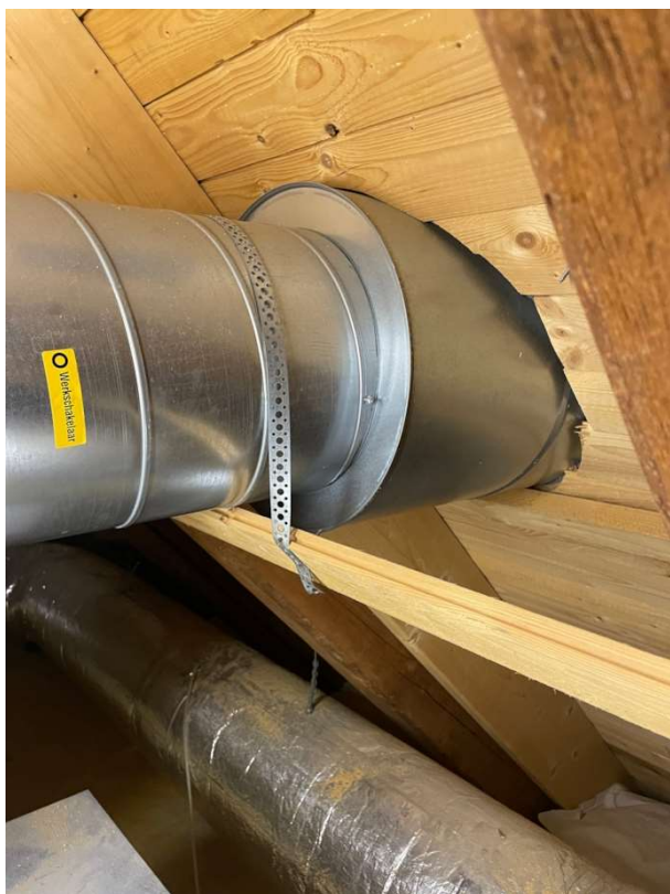
Afkast ud gennem tagkonstruktion
