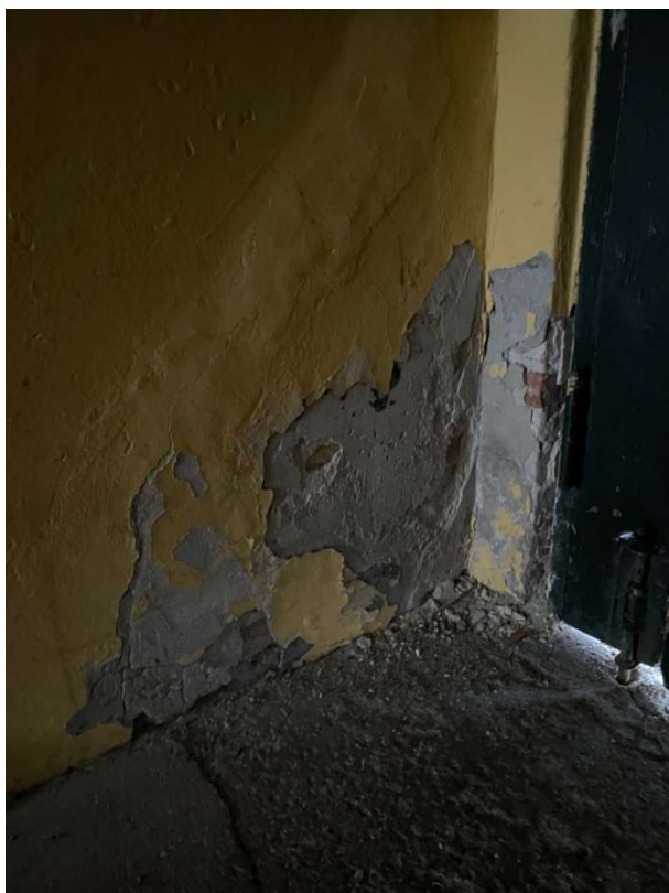
Renoveringsparat pudsede overflader
