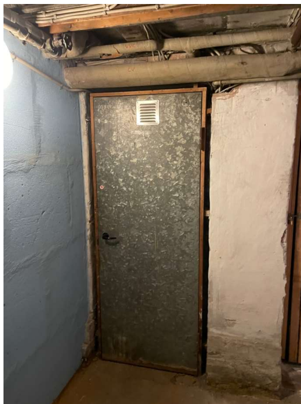
Dør mod teknikrum - udført med ventilationsrist
