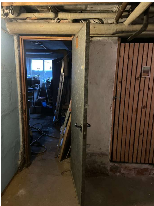
Dør mod teknikrum - udført med ventilationsrist
