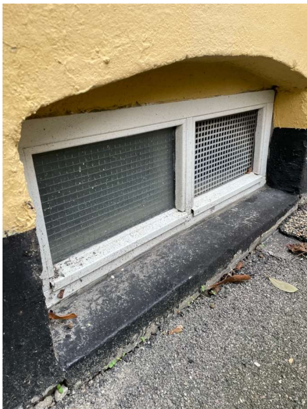
Kældervinduer udført med rist - medfører en konstant tilførsel af udeluft til kælder
