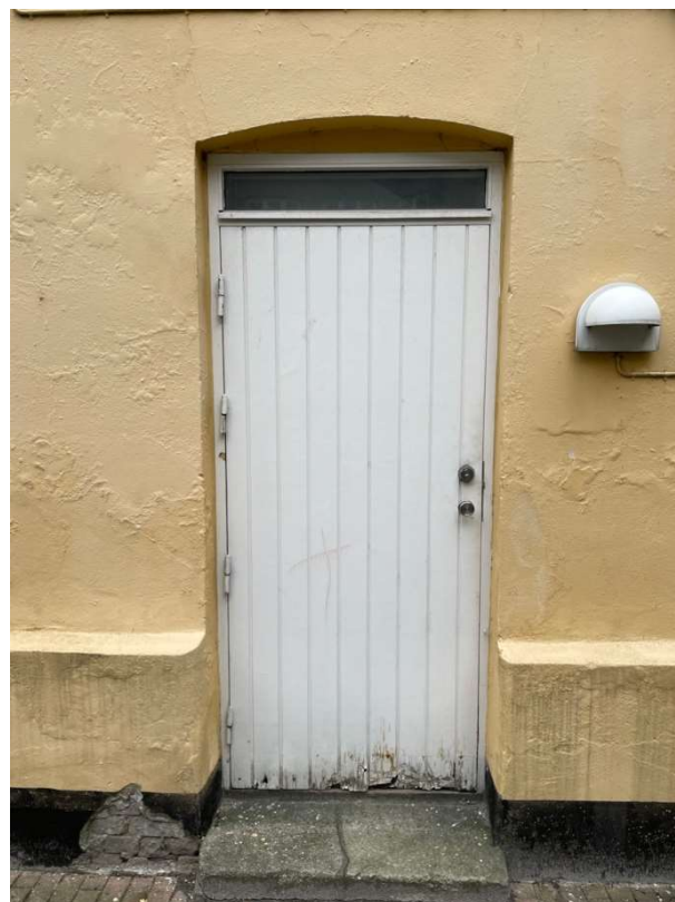
Renoveringsparat dør til bagtrappe
