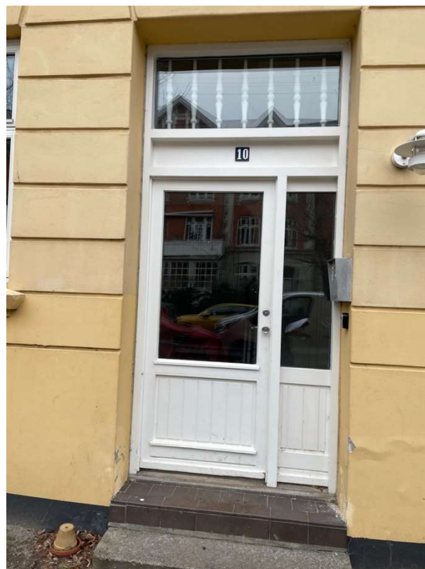
Opgangsdøre fra gade er udført med fyldninger, og glasfelt
