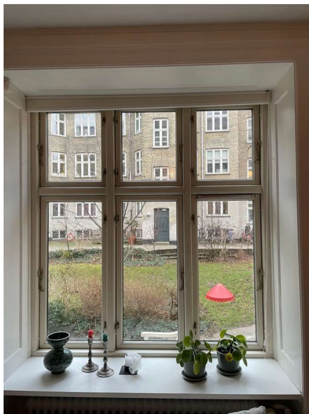
Vinder (træ/træ) - er udført med spalteventiler
