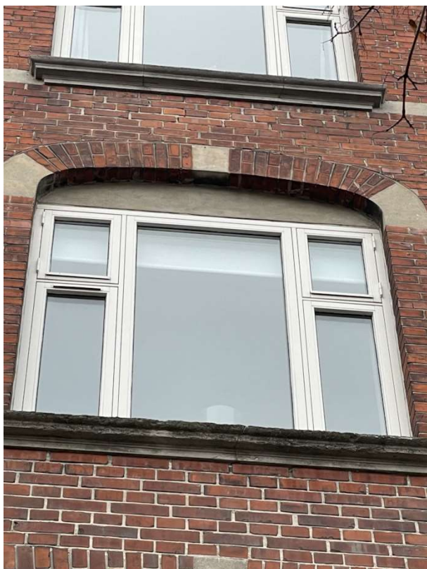
Vinder (træ/træ) - er udført med spalteventiler
