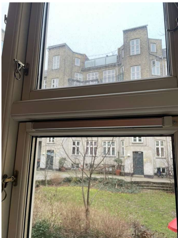
Vinder (træ/træ) - er udført med spalteventiler
