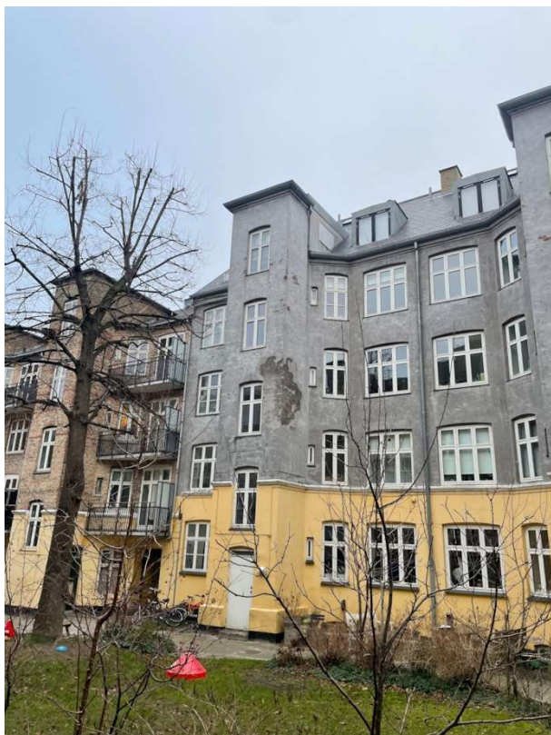
Gårdfacade: Udført med pudset underfacade og tyndpuds på overfacade
