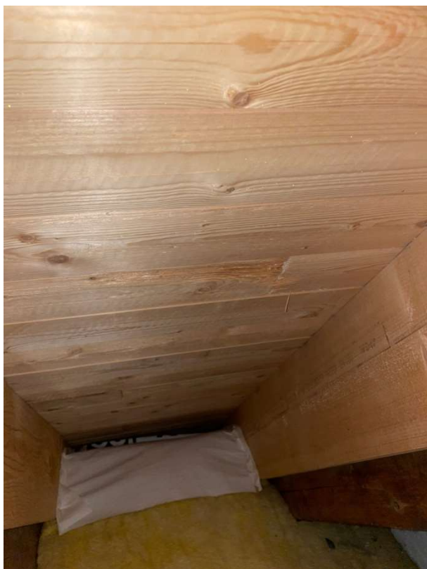
Sikring af luftspalte omkring hanebånd - med banevare
