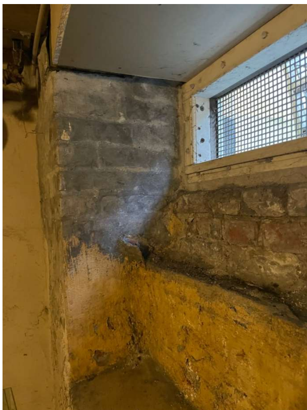
Princip for riste monteret i vinduespartier
