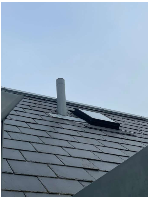
Gennemføringer udført med korrekt zinkinddækning - og fast underlag
