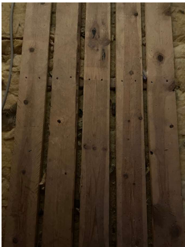
Gangbro udført i forskalling - placeret direkte på isolering
