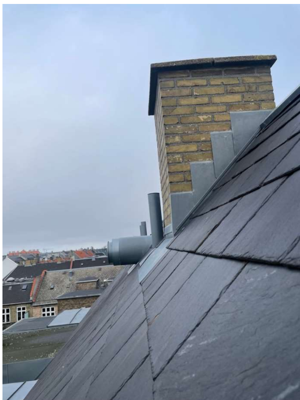
Lille skorsten er udført med optrappet inddækninger. Fremstår i god stand
