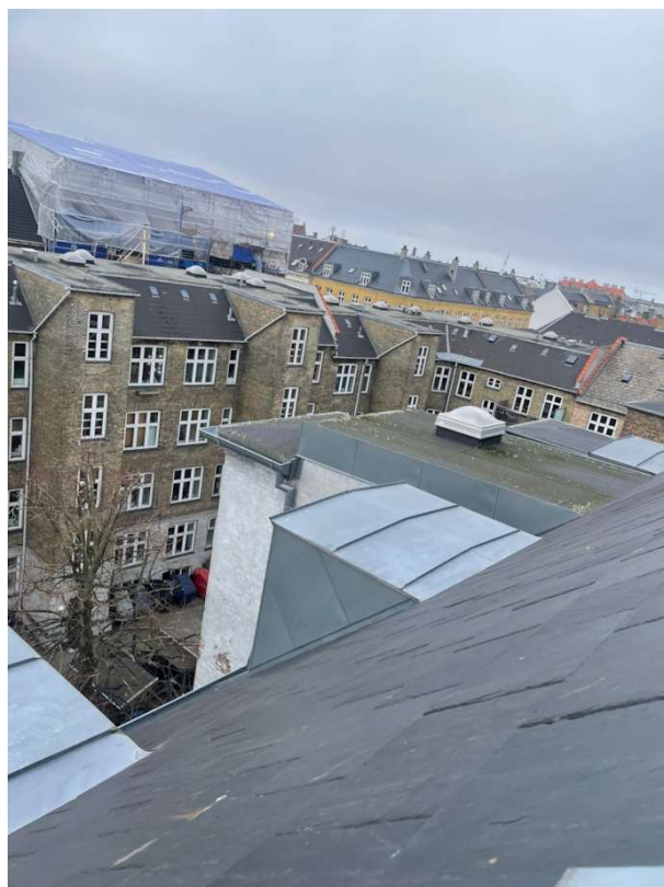
Tagflade beklædt med naturskifer. Kviste er udført med falsede samlinger
